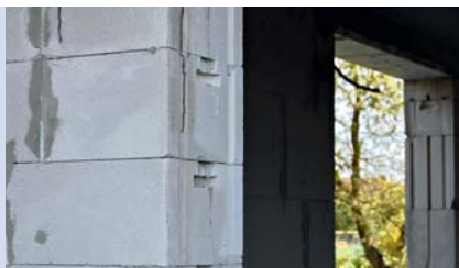
Diese Leibung benötigt noch einige Vorarbeit für eine funktionstüchtige Abdichtung.
