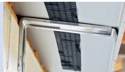
Fensterbank mit Entdröhnung und zusätzlichem Fensterbankhalter (Ansicht von unten)
