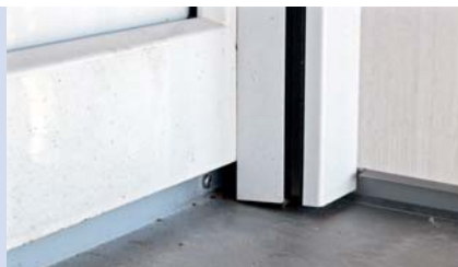
Wenn diese Rollladenschiene jetzt noch einen unteren Schrägschnitt hätte, wäre alles o.k.
