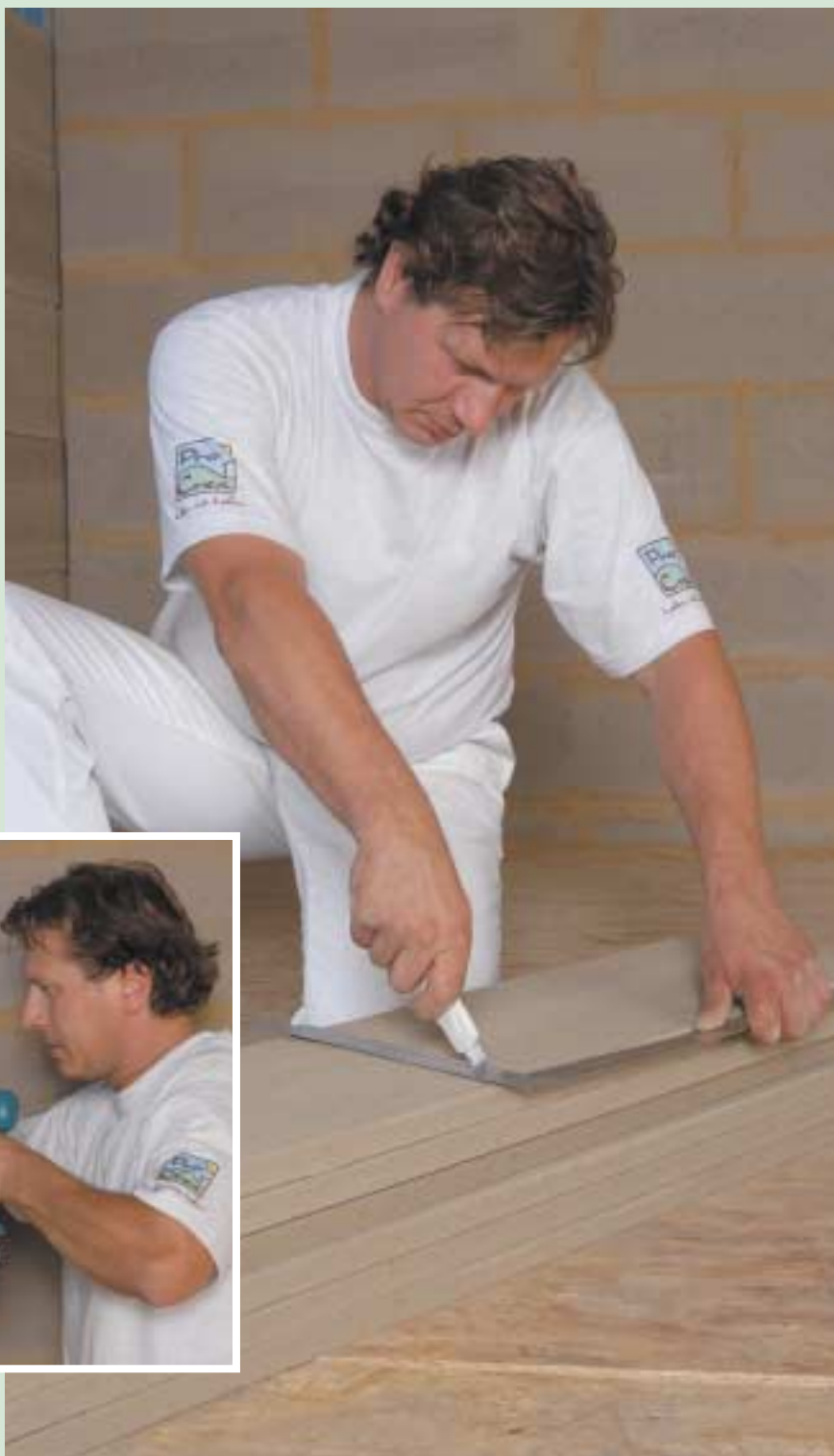
Lehmbauplatten lassen sich mit üblichen Maschinen und Werkzeugen bearbeiten und montieren. Fotos: Hock
