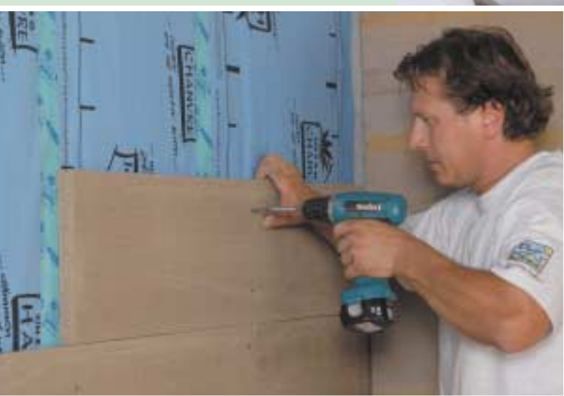
Lehmbauplatten lassen sich mit üblichen Maschinen und Werkzeugen bearbeiten und montieren. Fotos: Hock
